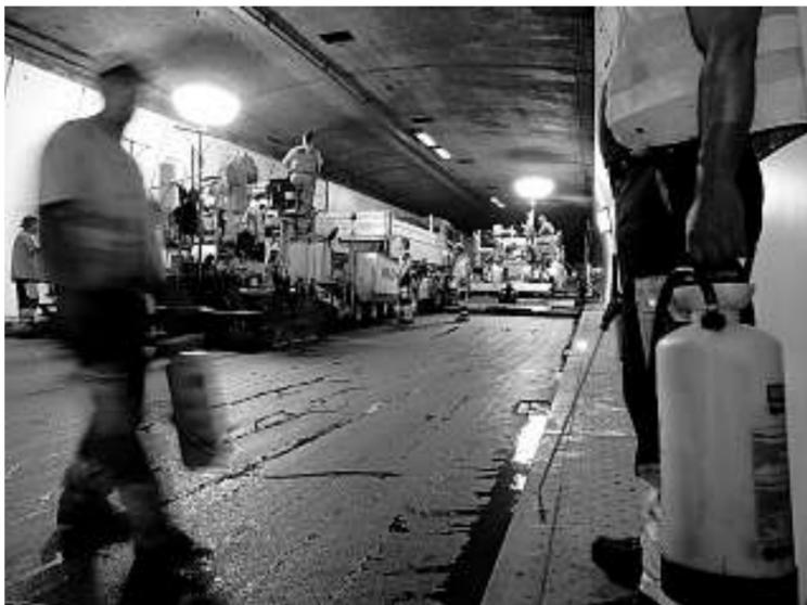
Letzte Arbeiten: Im Schichtbetrieb wird der Deckbelag in den neu sanierten San-Bernardino-Tunnel eingebaut. Bild Arno Balzarini/Keystone
